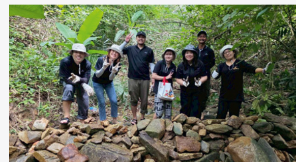
Bau von Kontrolldämmen für nachhaltige Wassereinzugsgebiete, Thailand.
